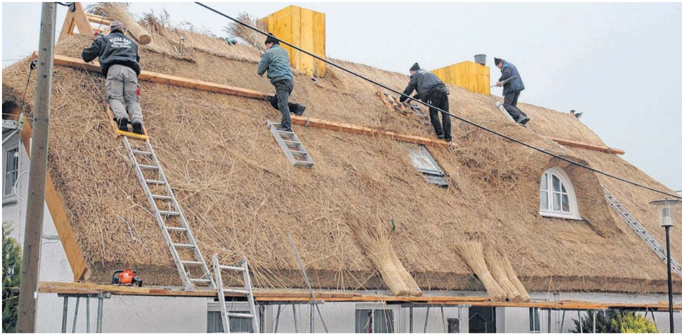
Vor allem auf den Inseln Usedom, Fischland-Darß und - wie hier in Groß Schoritz - auf Rügen ist der Bedarf an reetgedeckten Wohn- und Ferienhäusern groß. Die heimische Ernte reicht dafür nicht aus, deshalb muss Reet importiert werden. FOTOS (6): SOMMER
